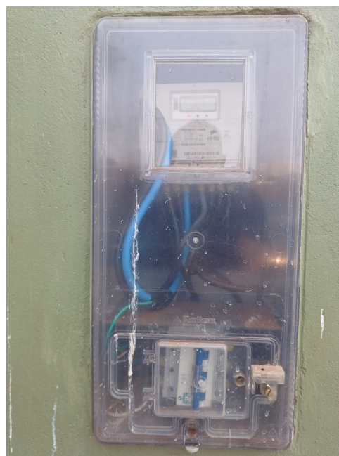
Medidor e Disjuntor de Proteção.
